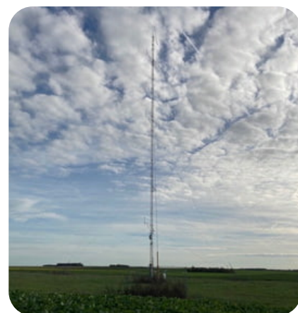
Mât de mesure / Source : RWE
